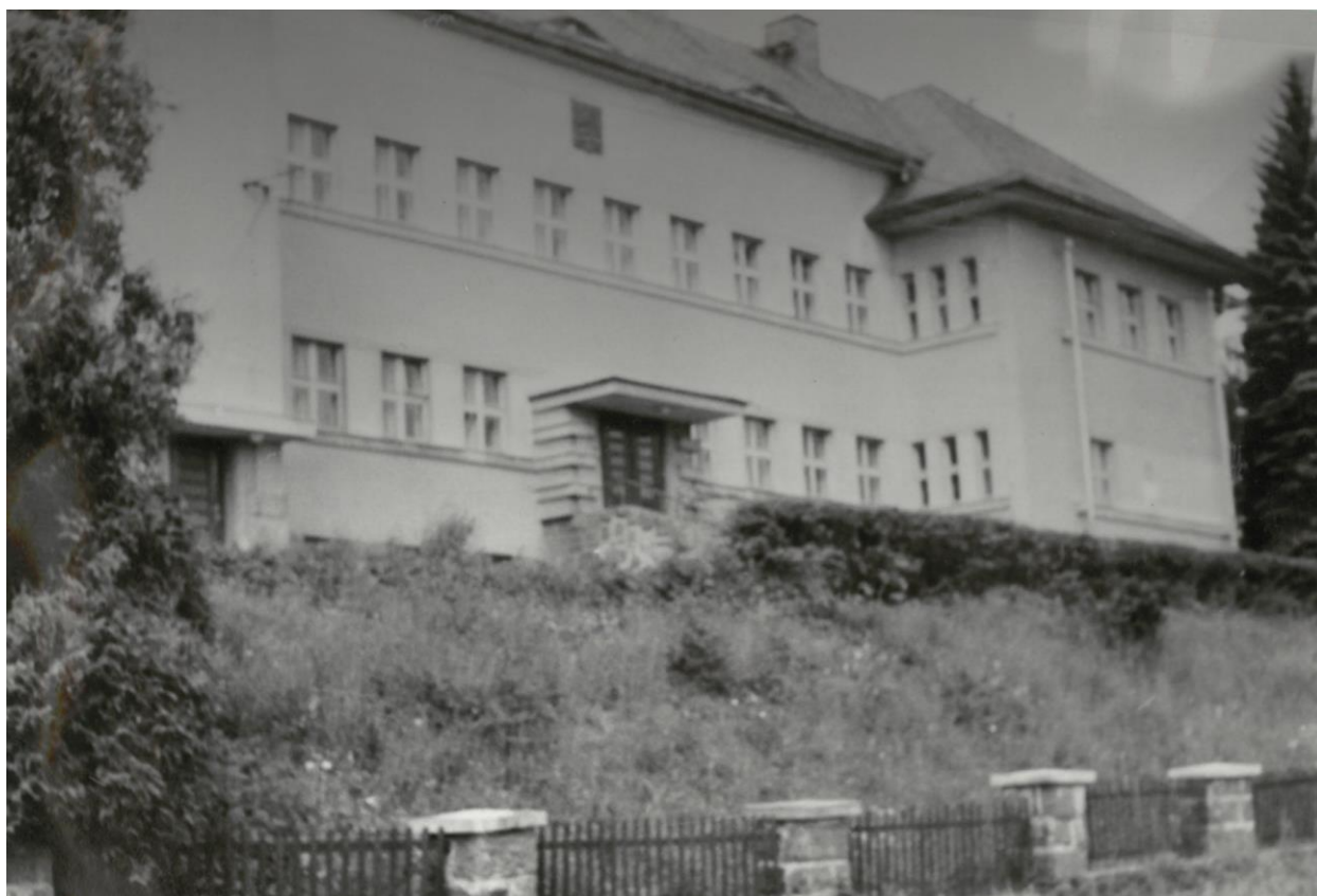
Obr. 10: Budova školy v roce 1983, zdroj: archiv školy
