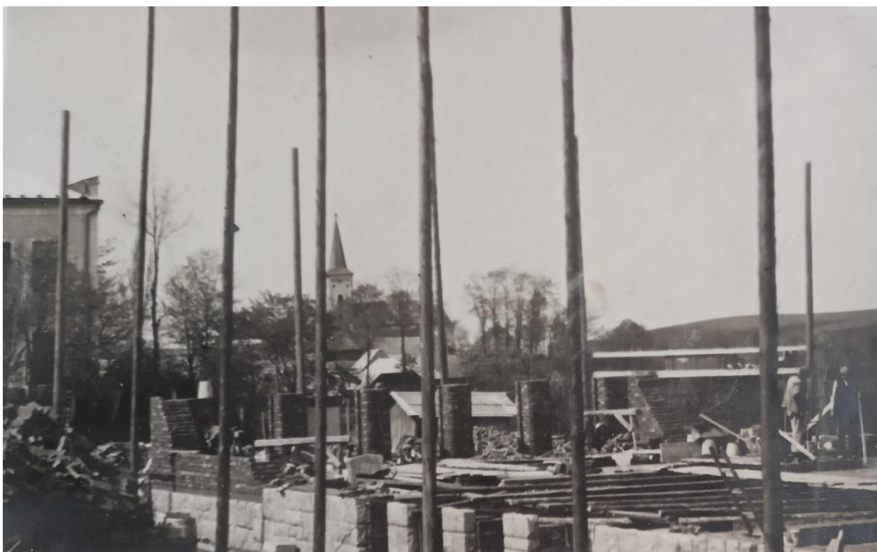
Obr. 4: Stavba školy, zdroj: archiv školy
